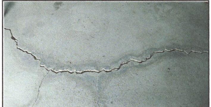
Foto 6: Reparación de piso de torta de concreto.
