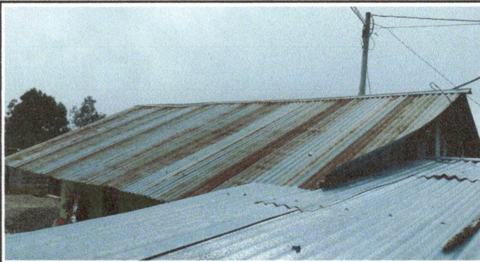
Foto 3: Mantenimiento a estructura de soporte de metal.
